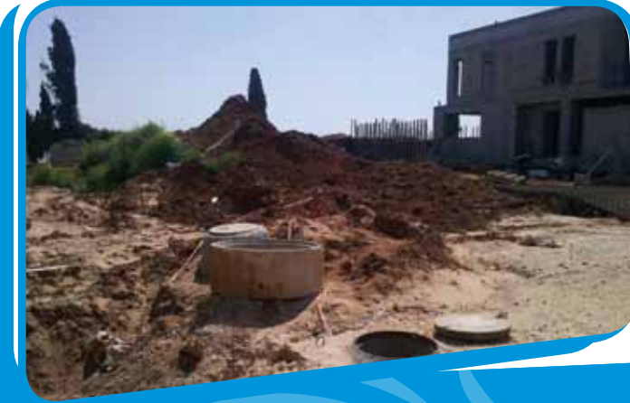
עבודות הנחת תשתיות מים וביוב מתחם 458
